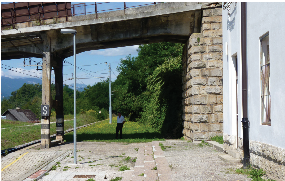
Železniška postaja Radovljica – brez ustrezne infrastrukture, neprilagojeno za osebe z ovirano mobilnostjo
