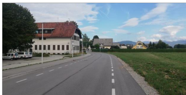
Slika 24 Obnovljena Gradnikova cesta v Radovljici
