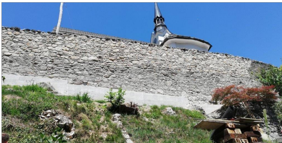
Slika 15 Sanacija opornega zidu v Kropi
