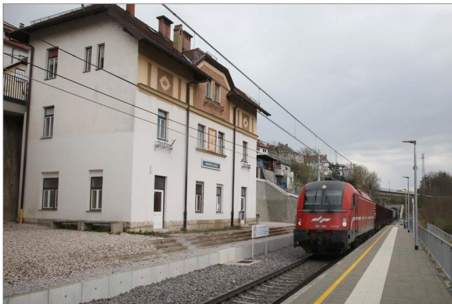
Slika 28 Zaključek del na železniški postaji v Radovljici
