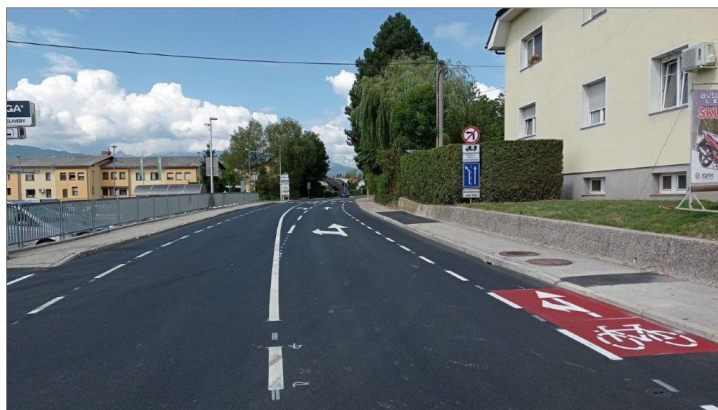
Slika 25 Obnovljena Alpska cesta v Lescah
