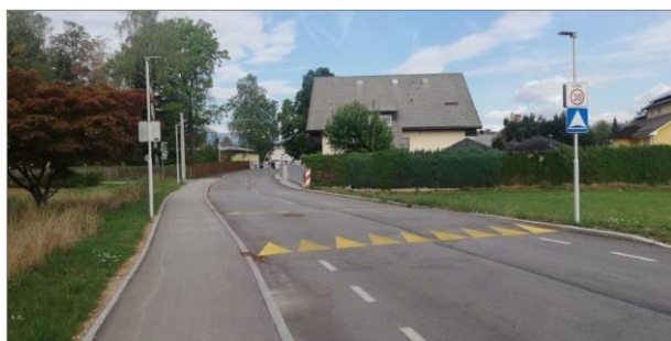
Slika 23 Umirjanje prometa na Gradnikovi cesti v Radovljici
